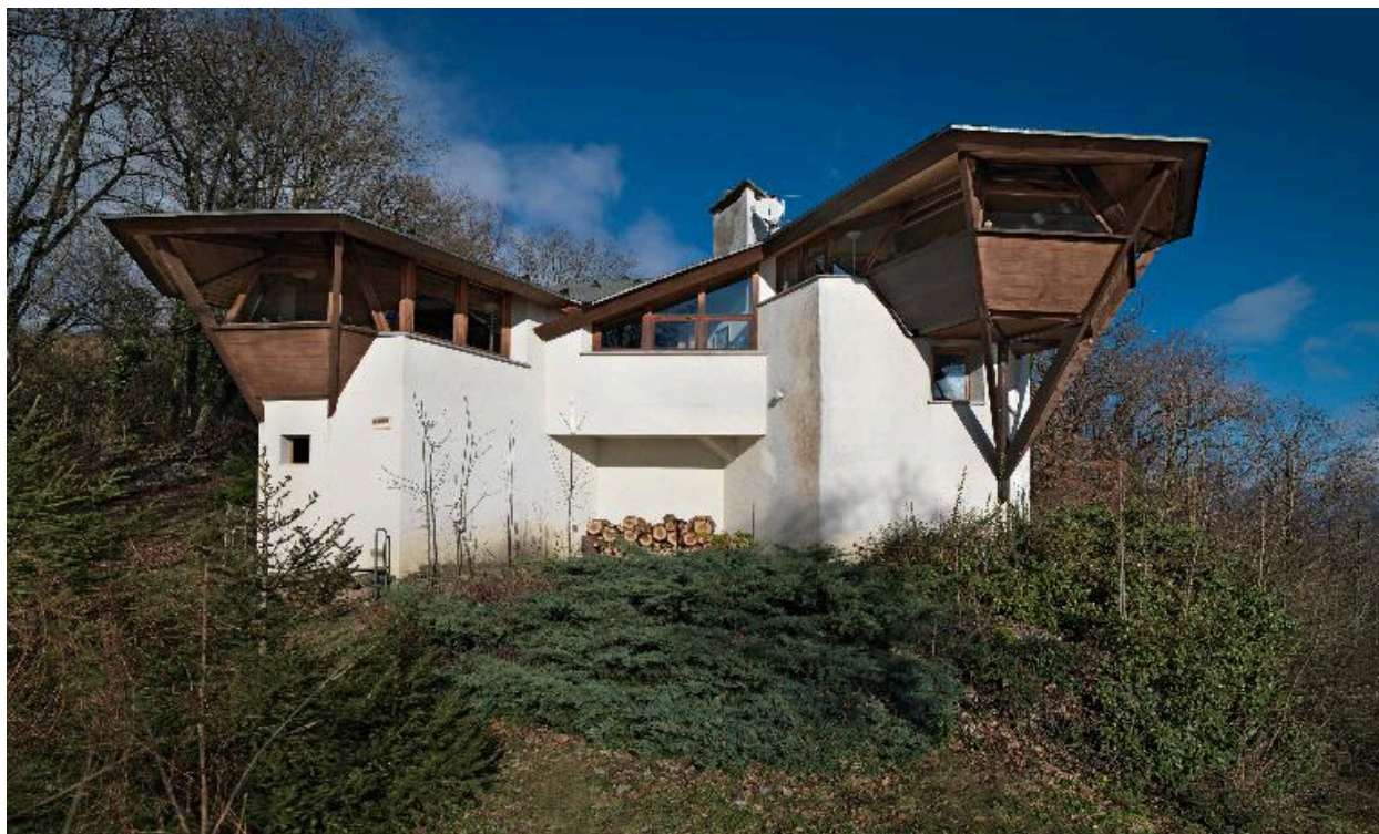
Vue rapprochée de la façade postérieure.
