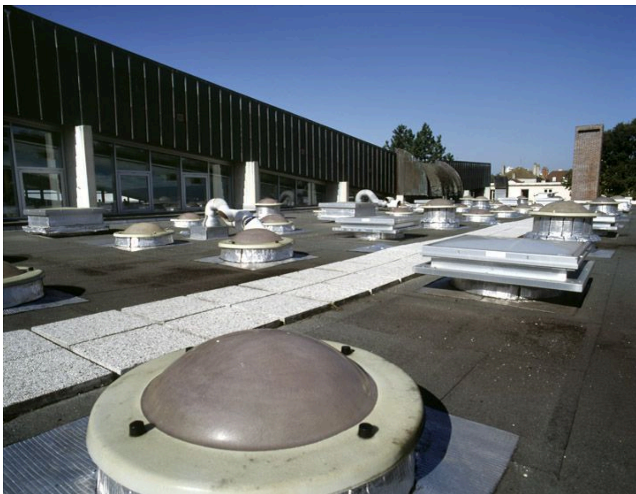
La piscine couverte : le toit-terrasse des vestiaires, avec ses bouches d'aération.
