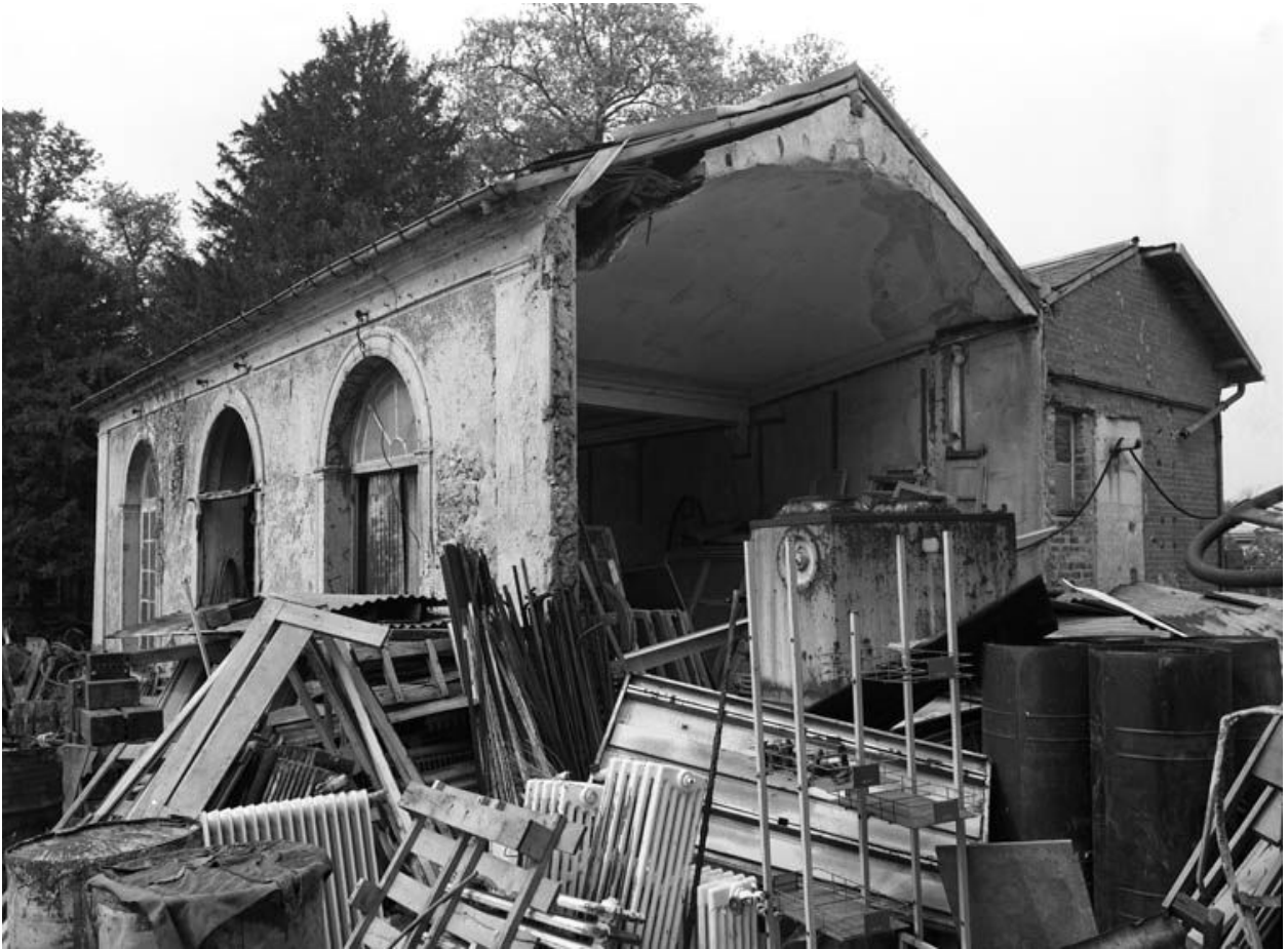
Le petit théâtre édifié par la famille Laveissière en cours de démolition. Cliché Pré-inventaire, 1974. (Région Ile-de-France, service patrimoines et inventaire, Cliché Pré-inventaire)
