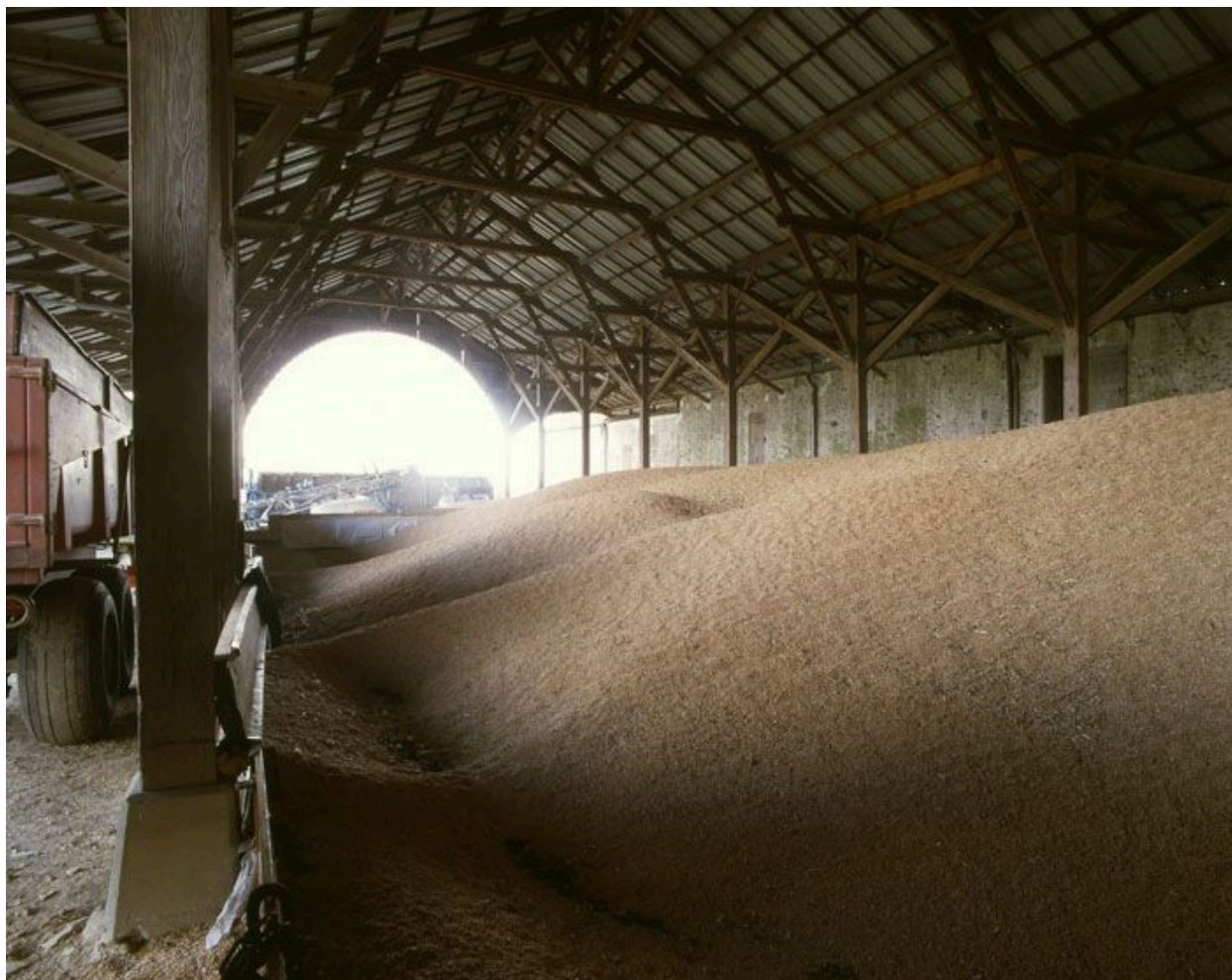
Vue intérieure de la charreterie qui sert aujourd'hui à stocker le blé.
