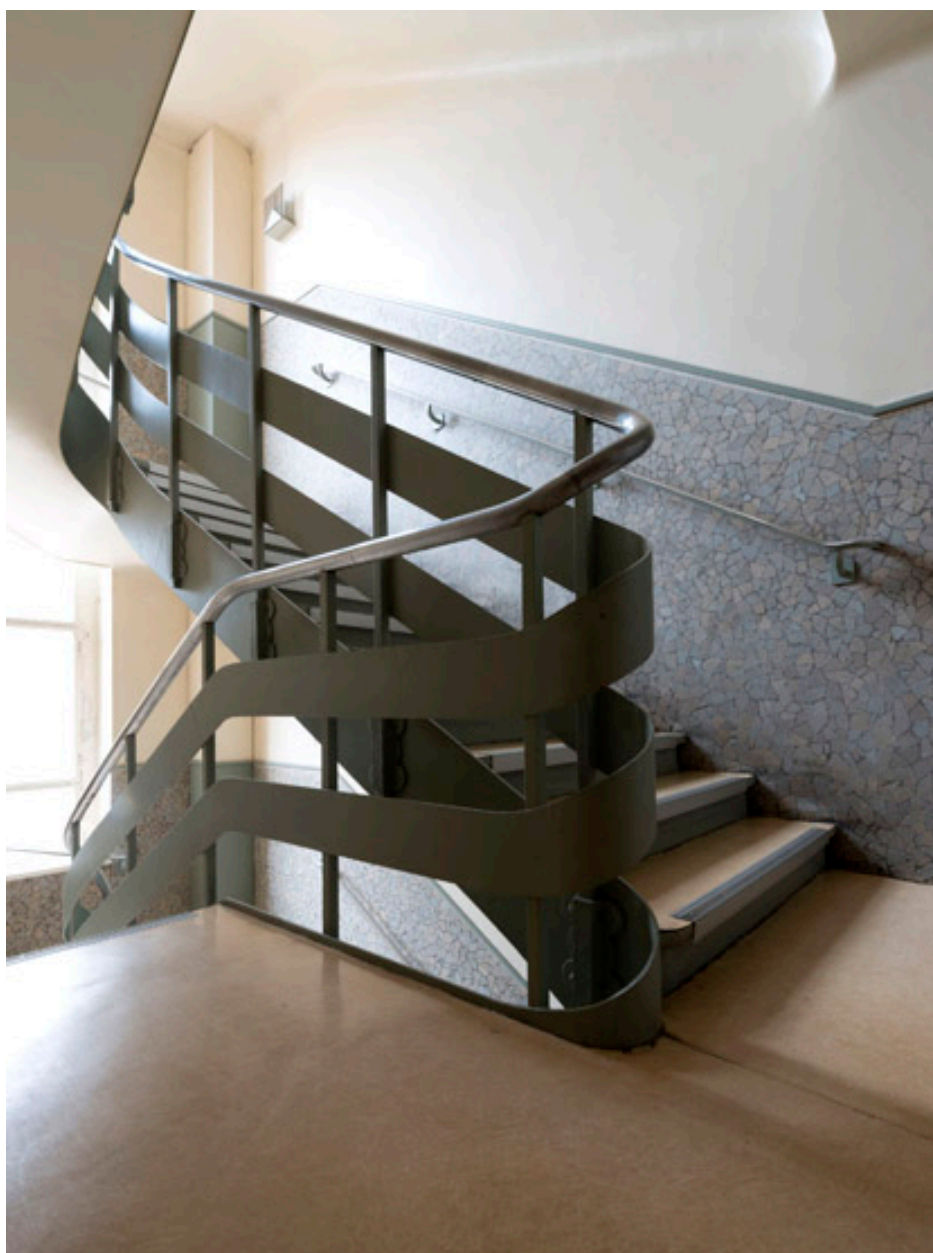
Vue d'un palier d'un escalier secondaire.
