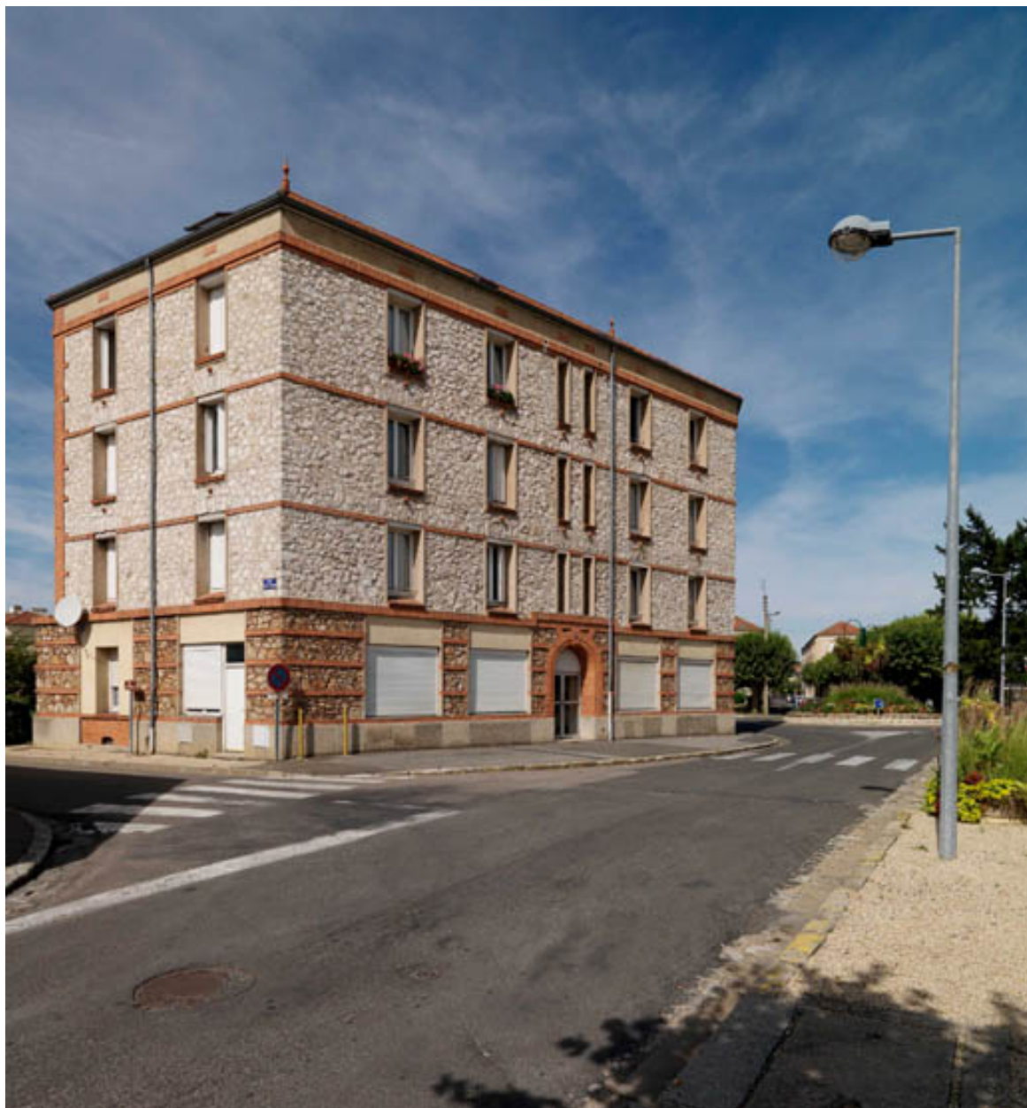
Immeuble 1 place Henri Schneider. Encadrement de porte monumental en briques rouges. Des cordons de briques marquent les niveaux
