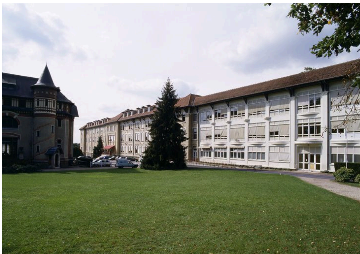
Vue d'ensemble en direction de la rue Alphonse-Daudet. Au premier plan à droite, le bâtiment de la cure d'air ; à gauche, la façade arrière de la villa Kermina.
