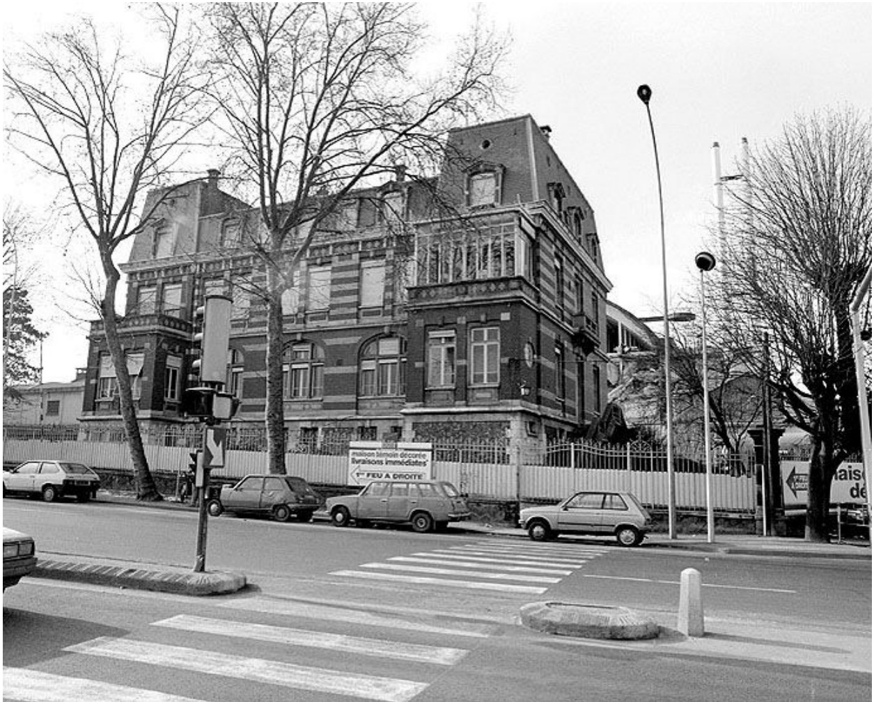
Bâtiment des bureaux : vue de la façade (élévation est), depuis l'avenue du Général-Leclerc. Photographie avant destruction, 1989. (Ministère de la culture, Inventaire général. 89SG695X)
