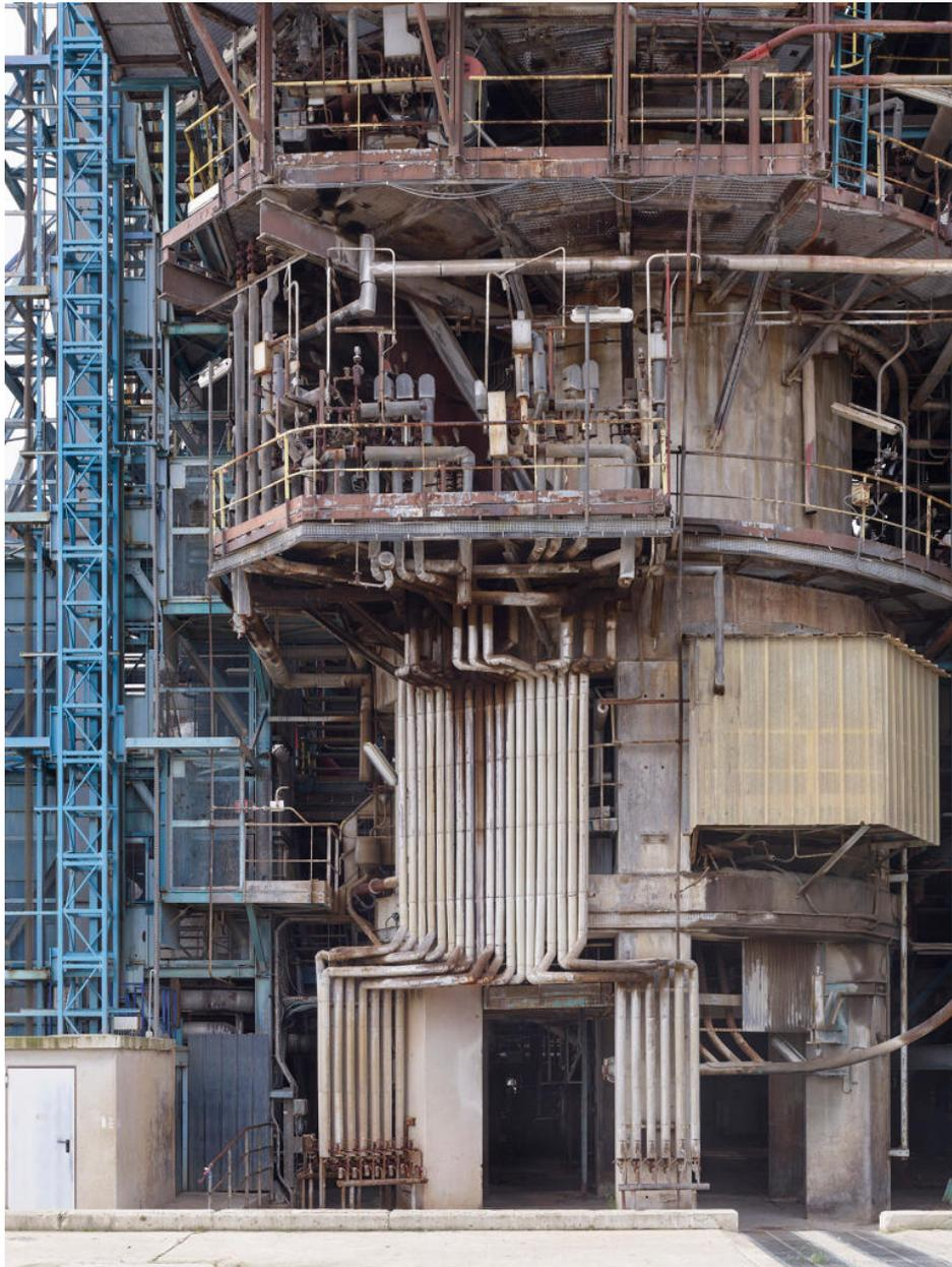
Unités Est - Zone FCC (Unité 651). Centre de l'image, lignes de traçage vapeur et de retour de condensats destinées au réchauffage des tuyauteries. En bas à droite, au premier plan, la conduite de fluidisation du catalyseur du régénérateur de l'unité. À gauche, en bleu, l'ascenseur de la zone.
