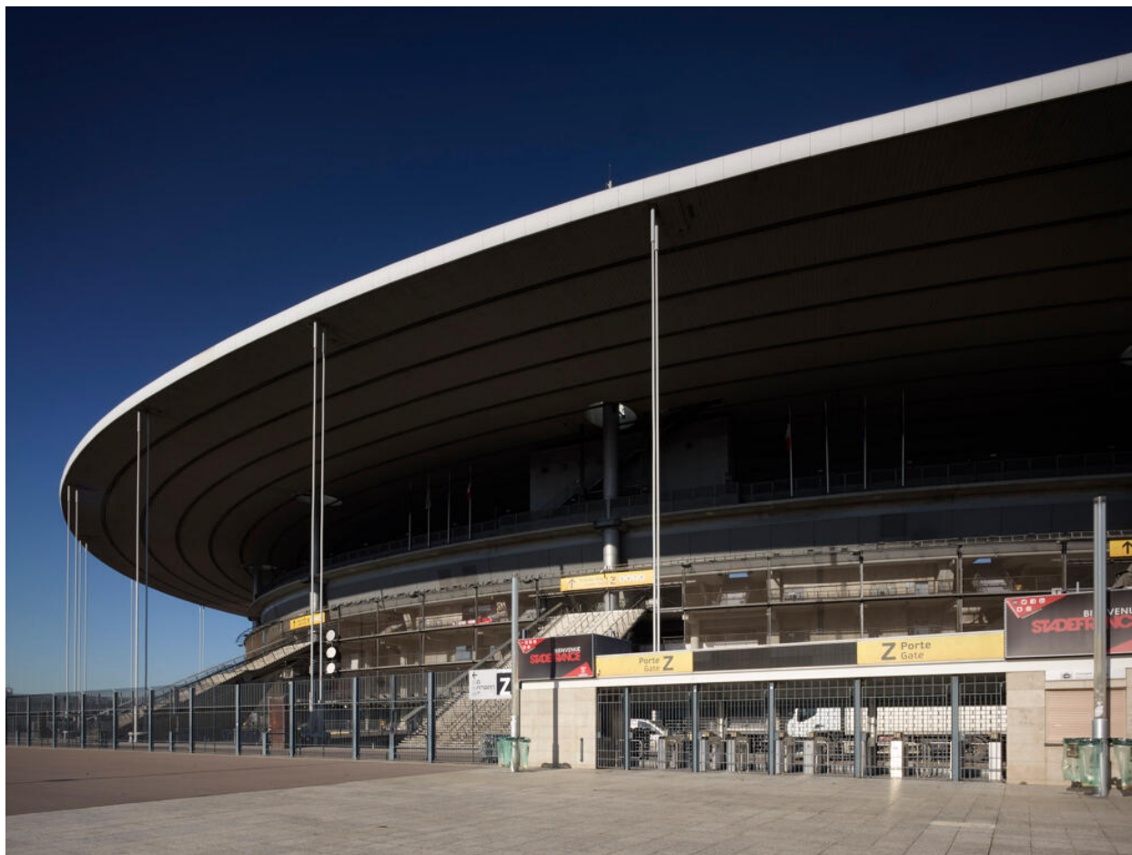
Stade de France. Portes d'entrée.
