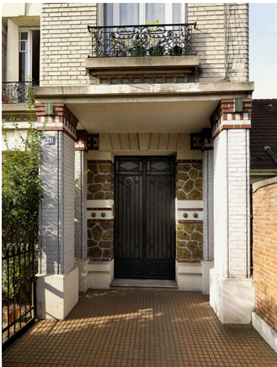
Vue du porche d'entrée de l'immeuble.
