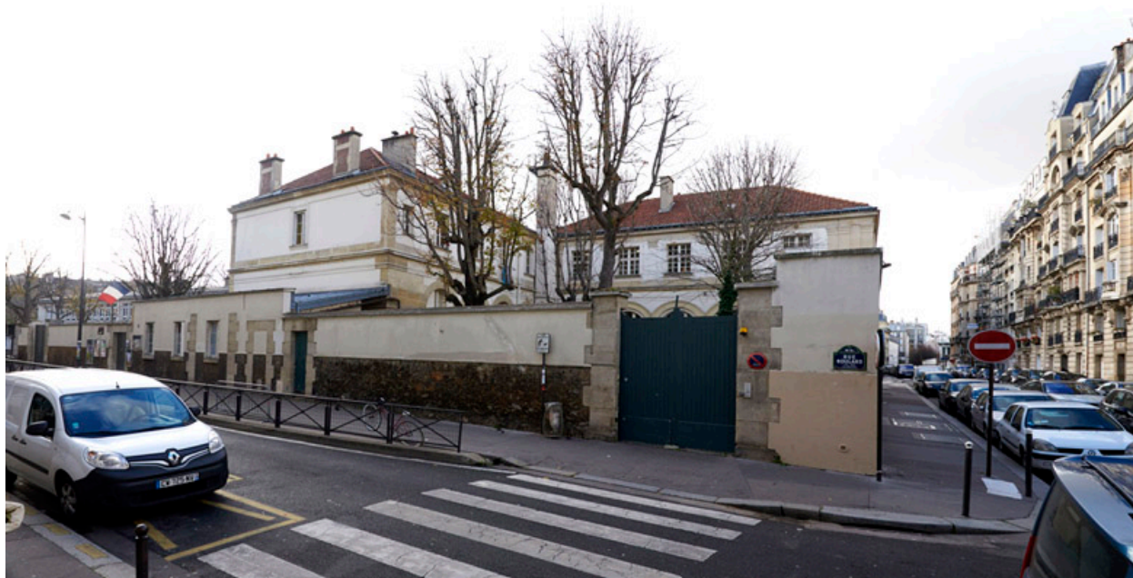
Vue de l'angle de la rue Boulard et de la rue Charles Divry.
