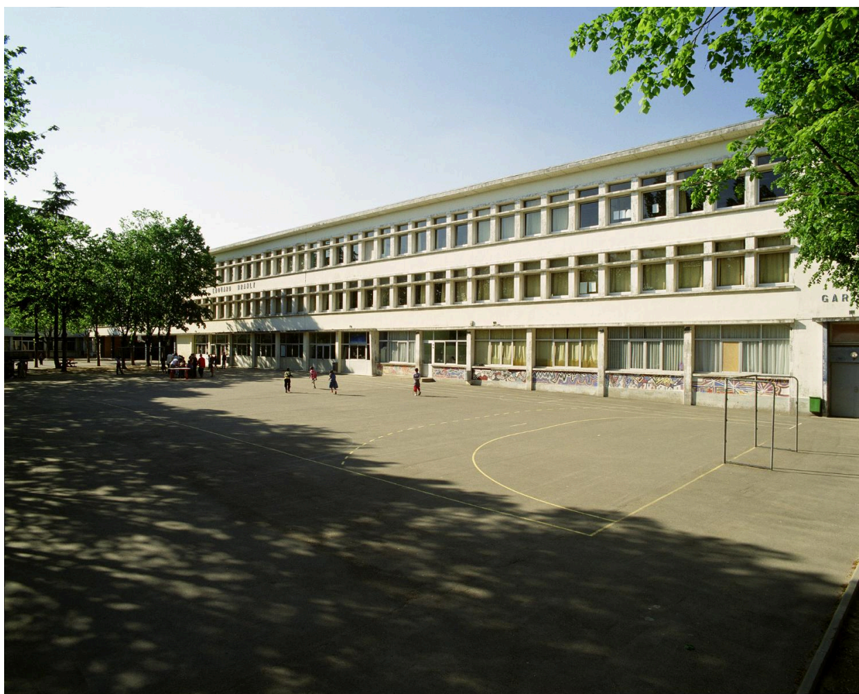
Façade du groupe scolaire sur la cour de récréation.
