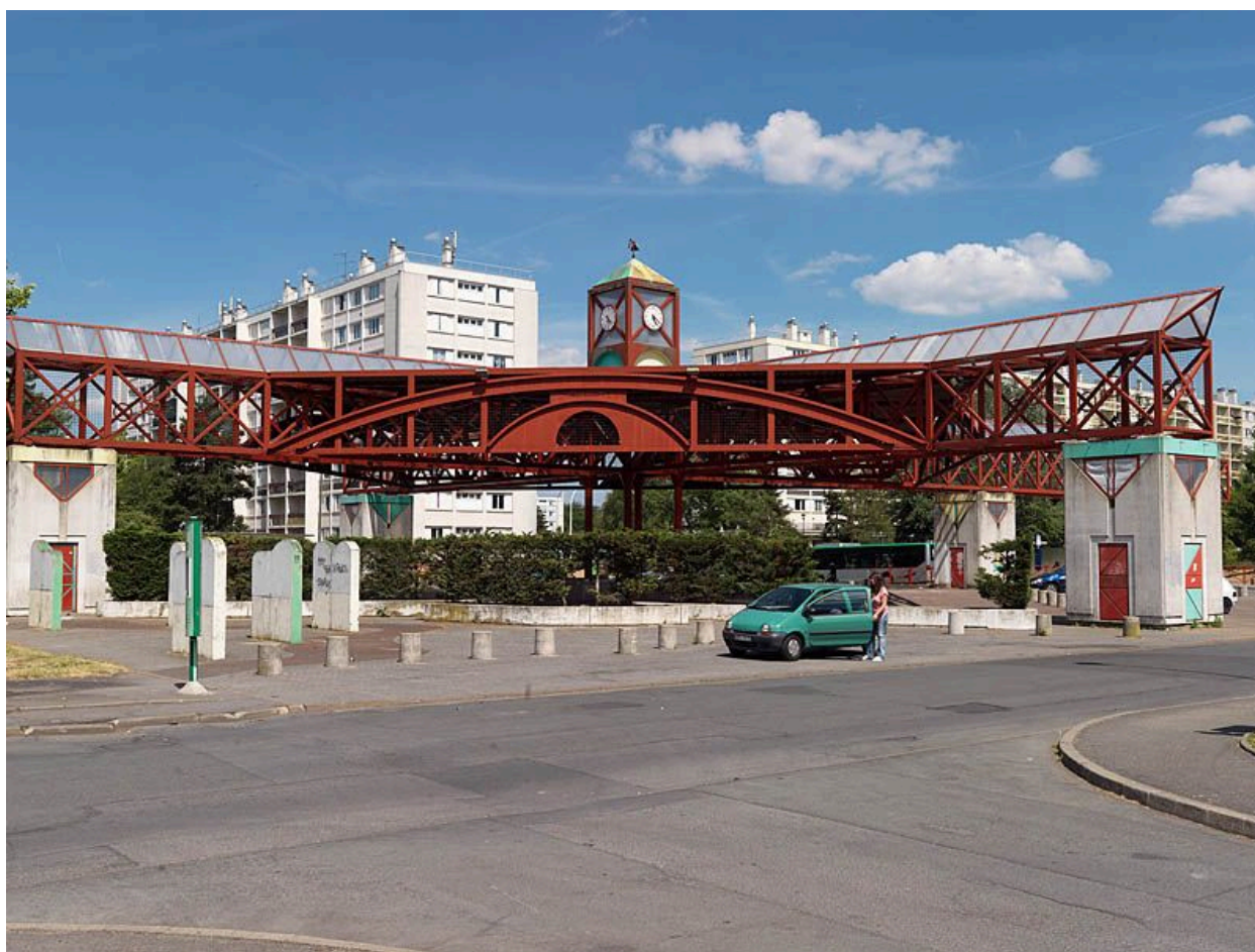
Cité dite Résidence Saint-Hubert. La structure en métal rouge de l'ancien centre commercial surmontée d'un clocheton.
