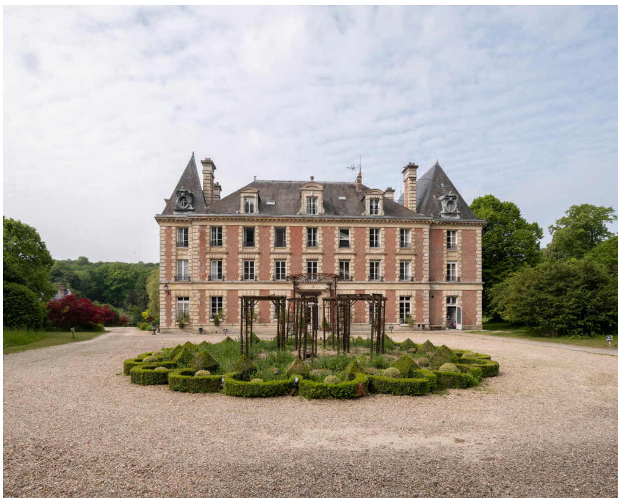
La façade nord-est, sur cour.
