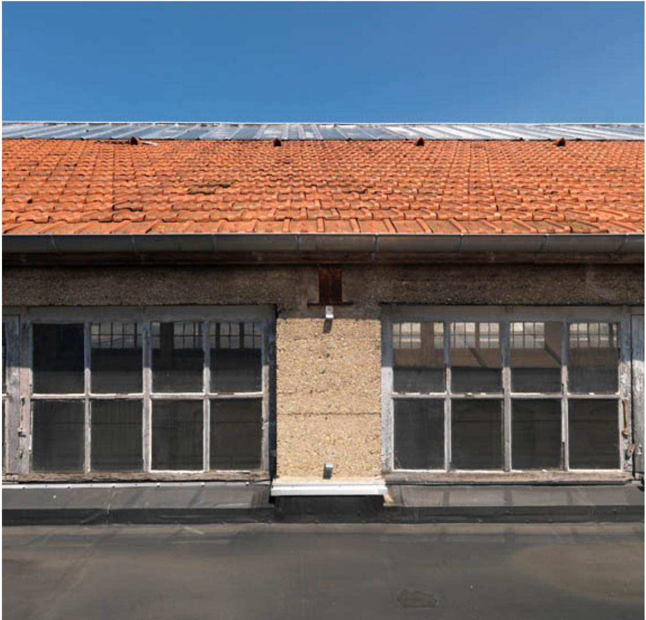
Toit d'une des liaisons longitudinales : au sommet, une verrière, puis des tuiles. Sur les côtés, des petites baies vitrées.
