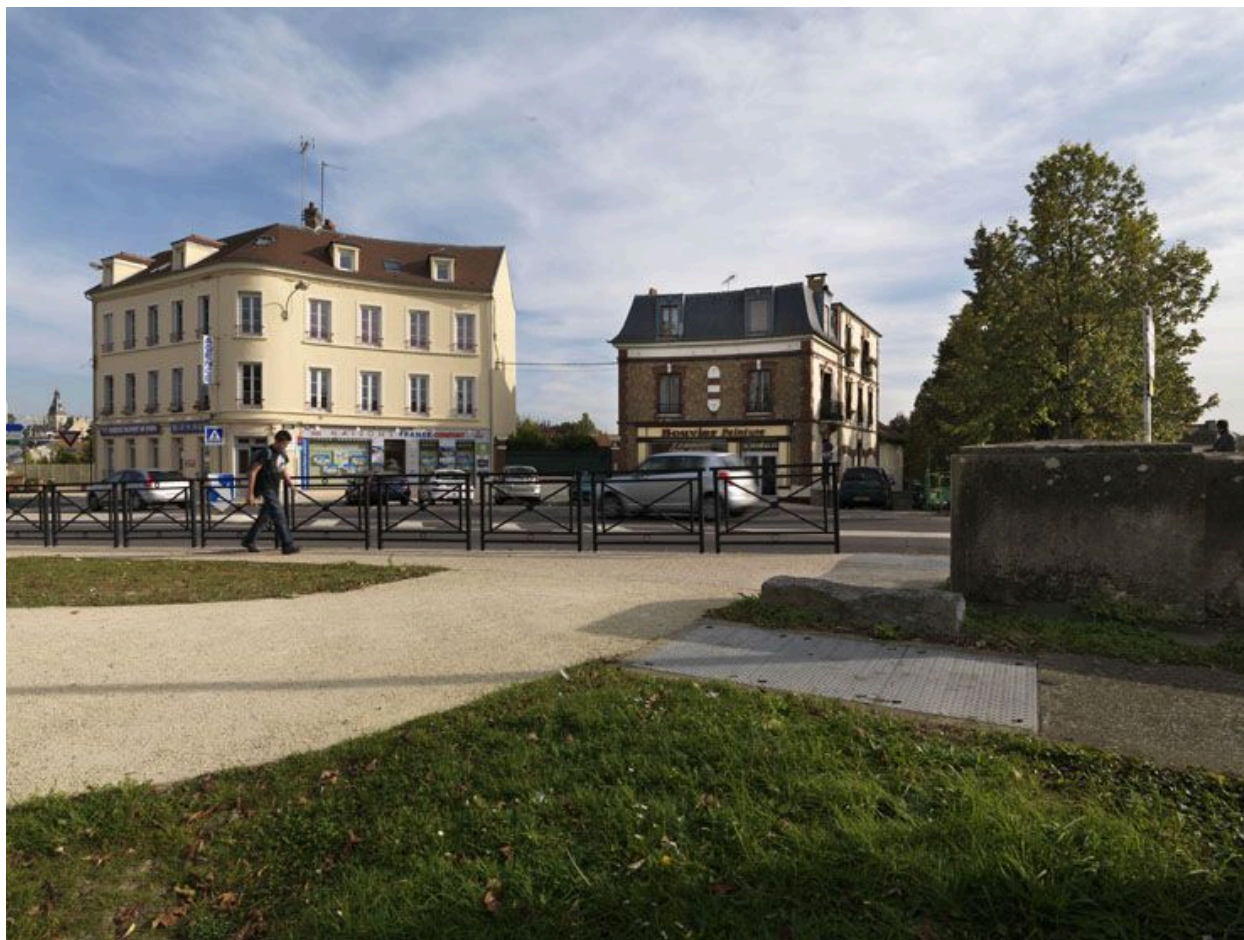
Limay : vue de la place aménagée à l'entrée du pont.
