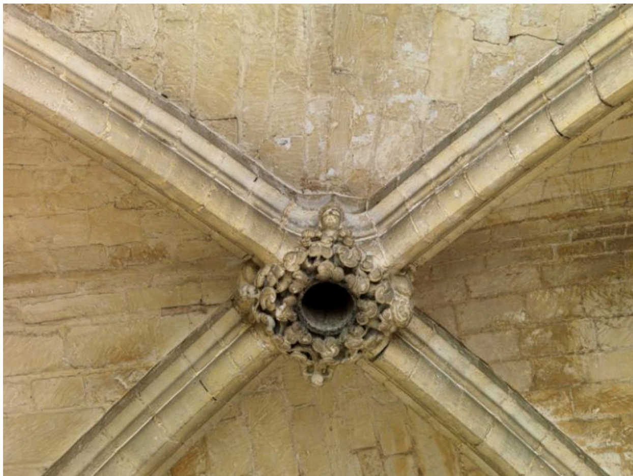
Vue d'une clef de voûte.
