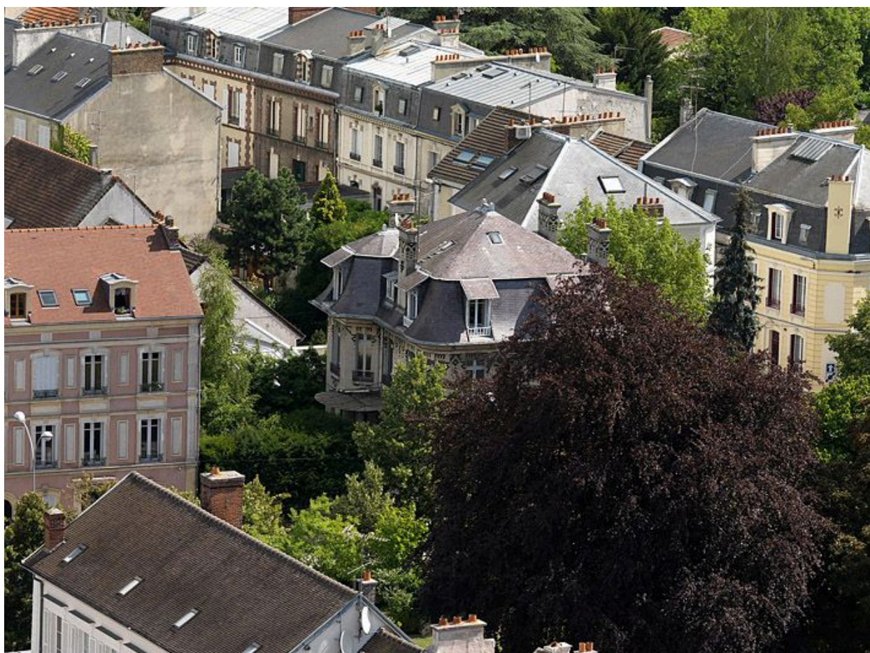
Le toit et l'environnement de la villa, vue prise depuis le clocher de la cathédrale.
