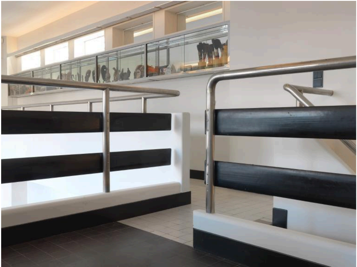
Détail du garde-corps de la mezzanine de l'atelier de Mallet-Stevens
