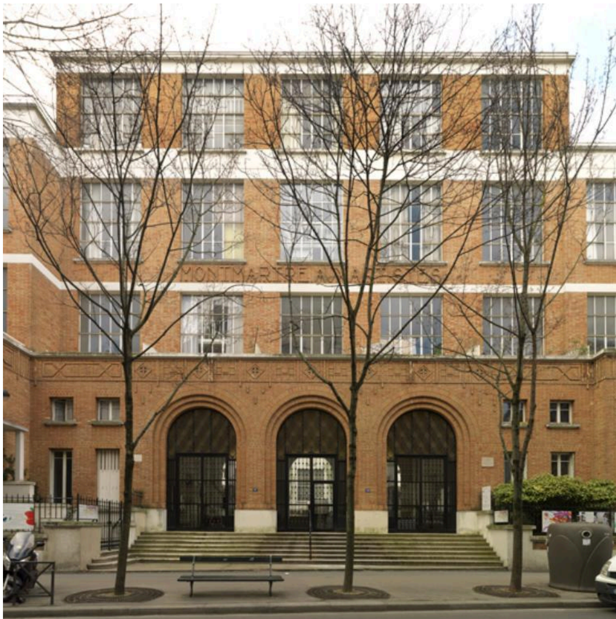
Vue rapprochée du bâtiment central
