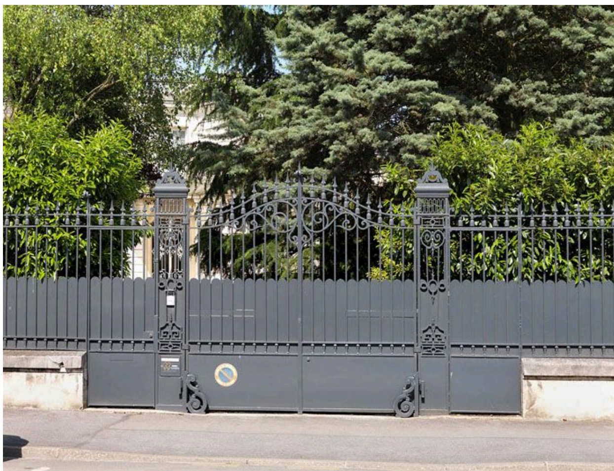
Le portail et la grille, vus de la rue.
