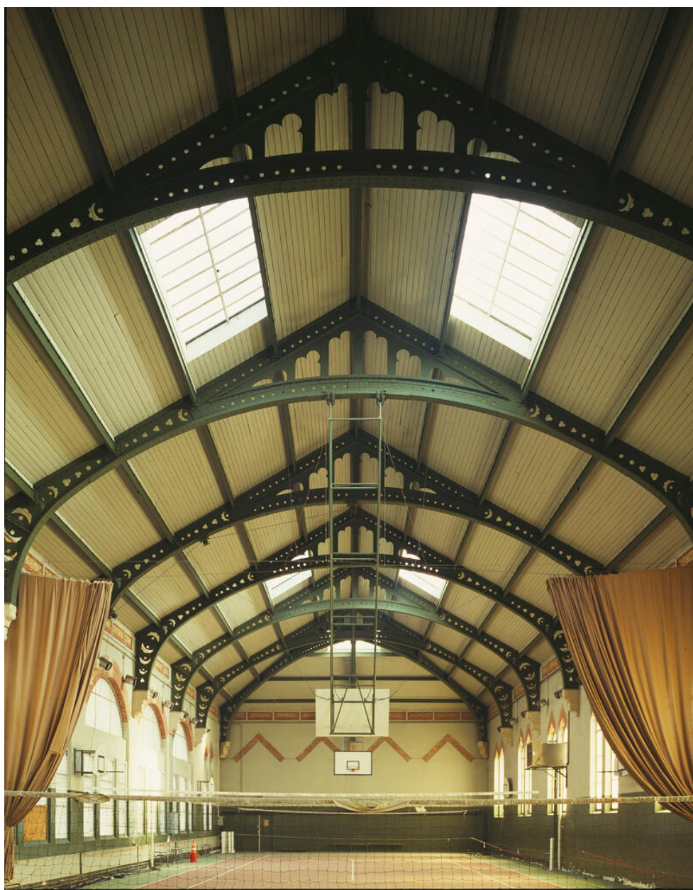
Gymnase. Vue intérieure depuis l'entrée.
