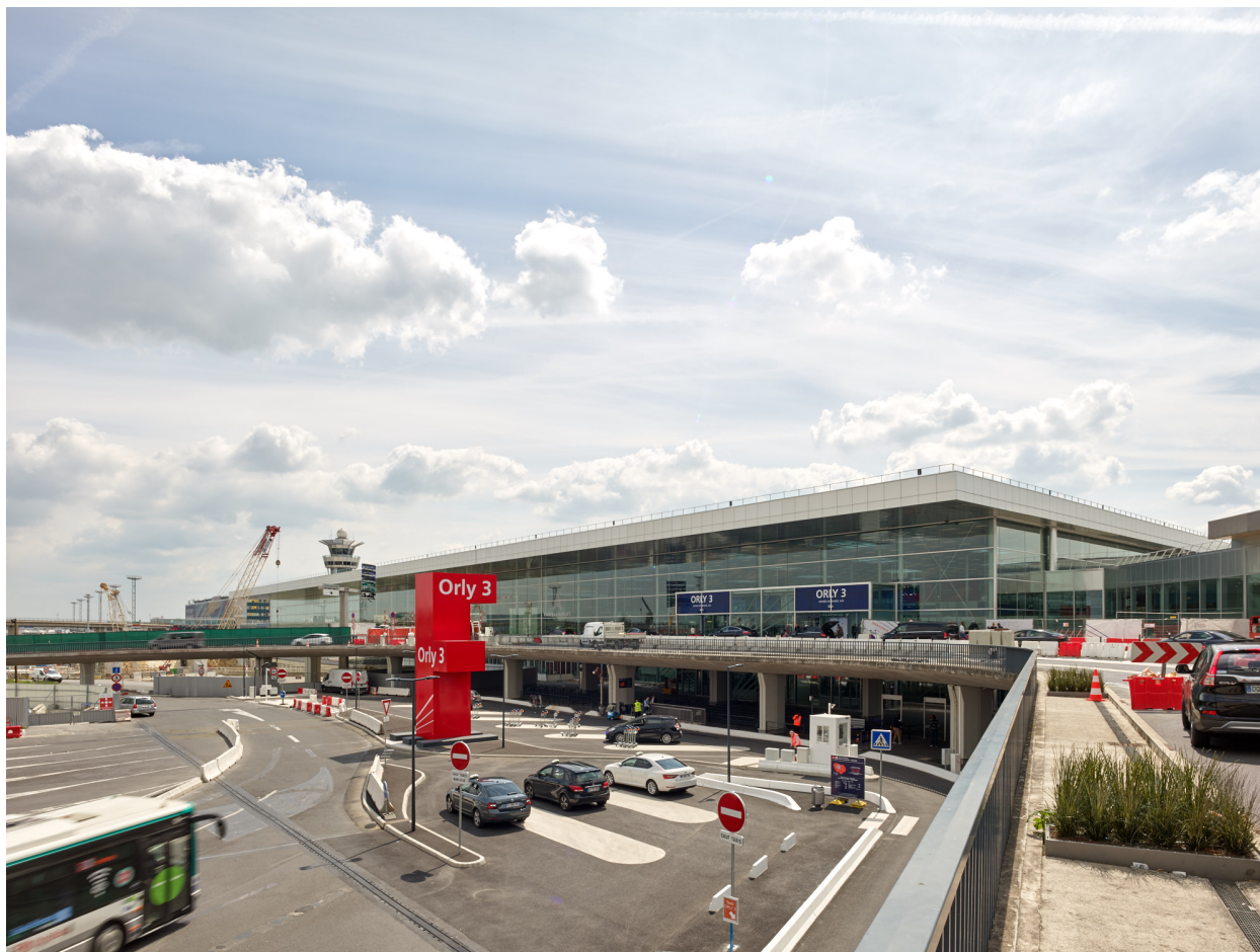
2019, Orly 3 coté ville, vue prise depuis le nord ouest.
