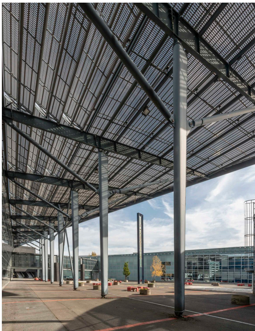
Détail du brise-soleil.
