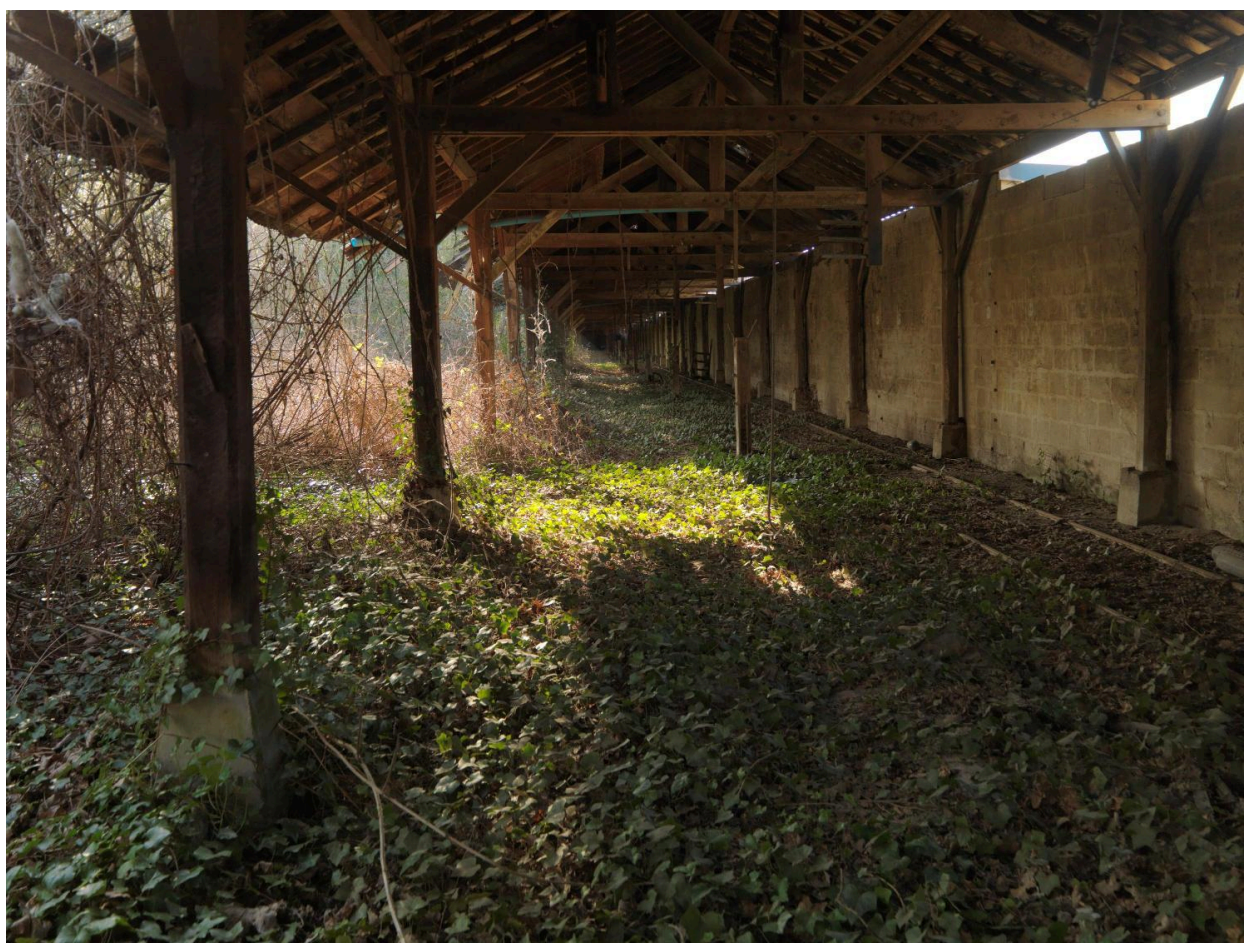
Vue générale du hangar de production des cordes et torons.
