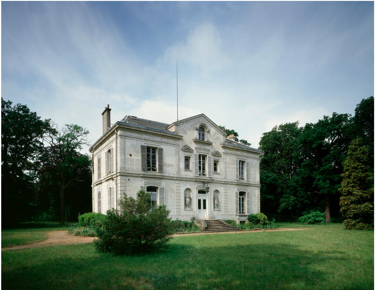
Vue d'ensemble de la façade antérieure.
