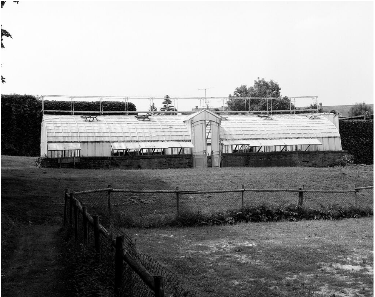
La serre, vue latérale.
