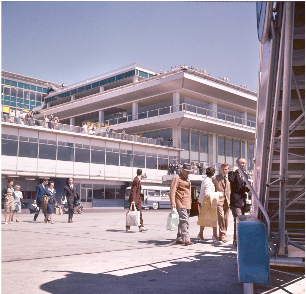
1961, l'embarquement des passagers: l'accès à l'avion à pied.
