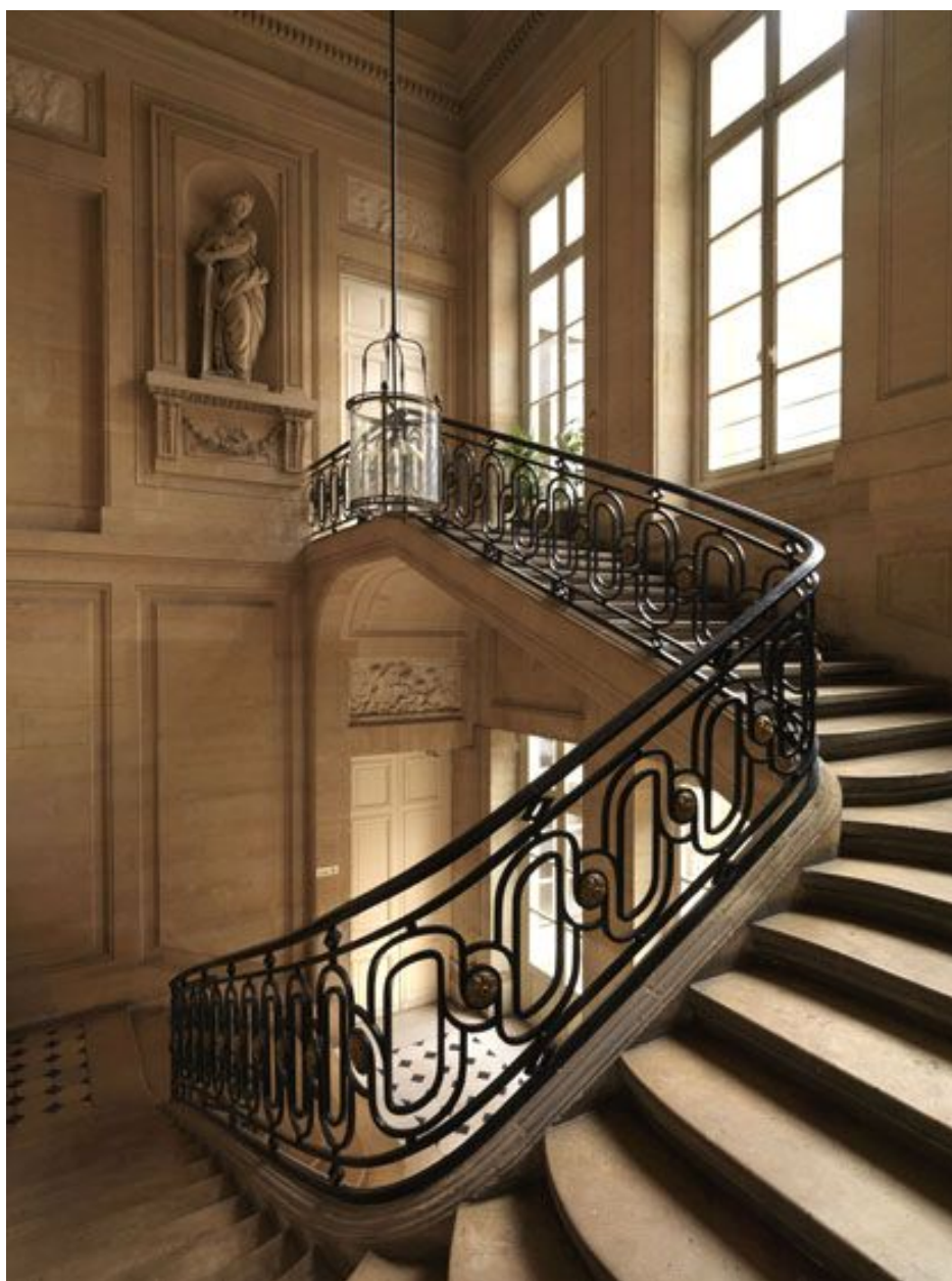
Vue de la rampe à arcades doubles.
