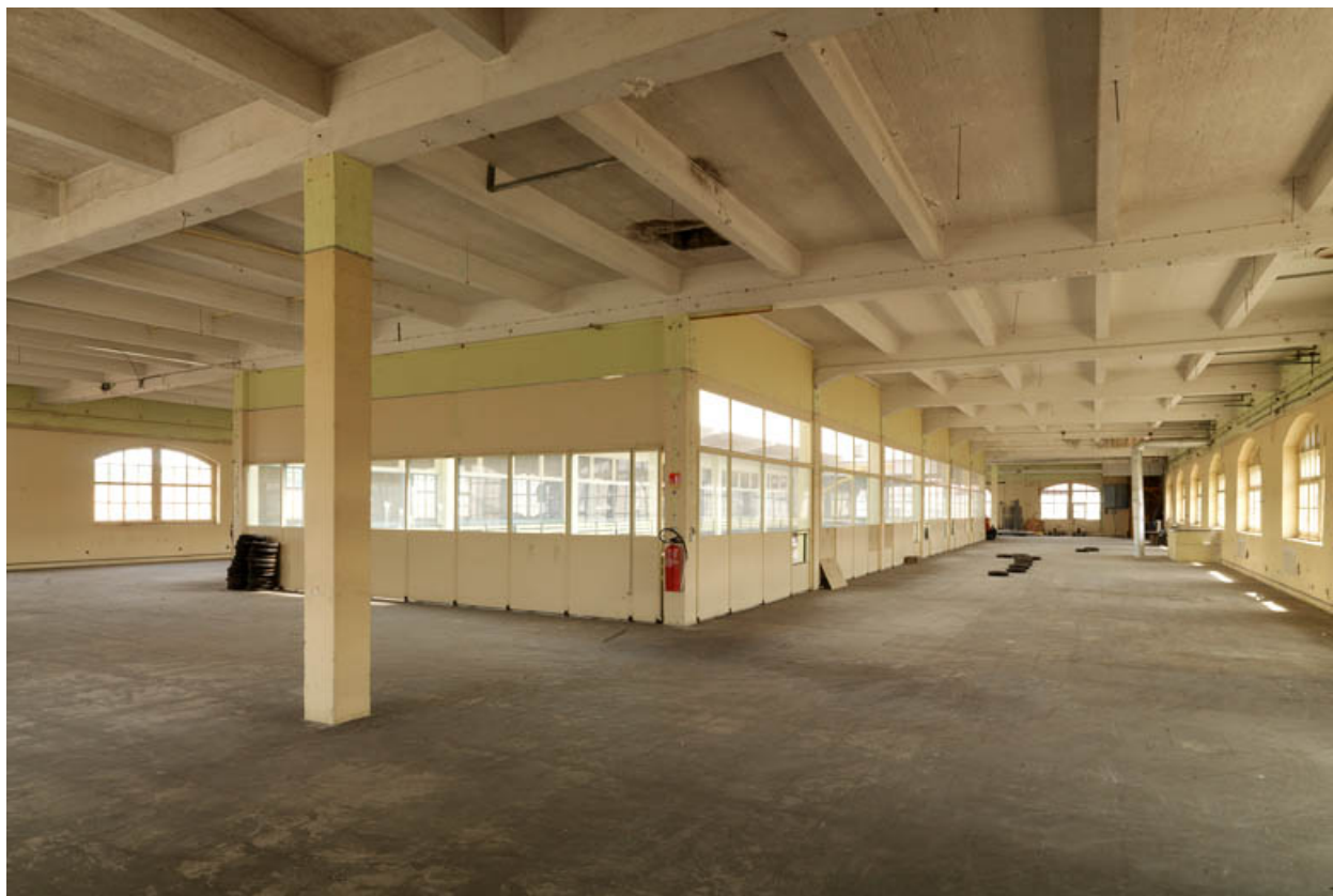
Vue intérieure du magasin général (1915). Structure en béton.
