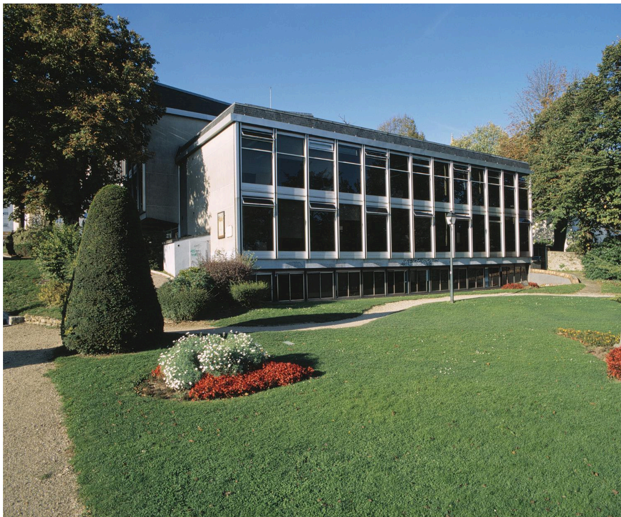
Bâtiment annexe de la mairie construit en 1971 par J. Goldstein.
