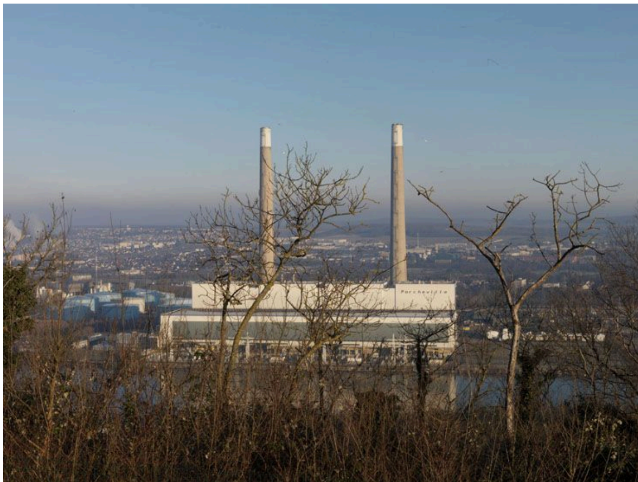
Guerville : centrale électrique de Porcheville vue depuis La Plagne.
