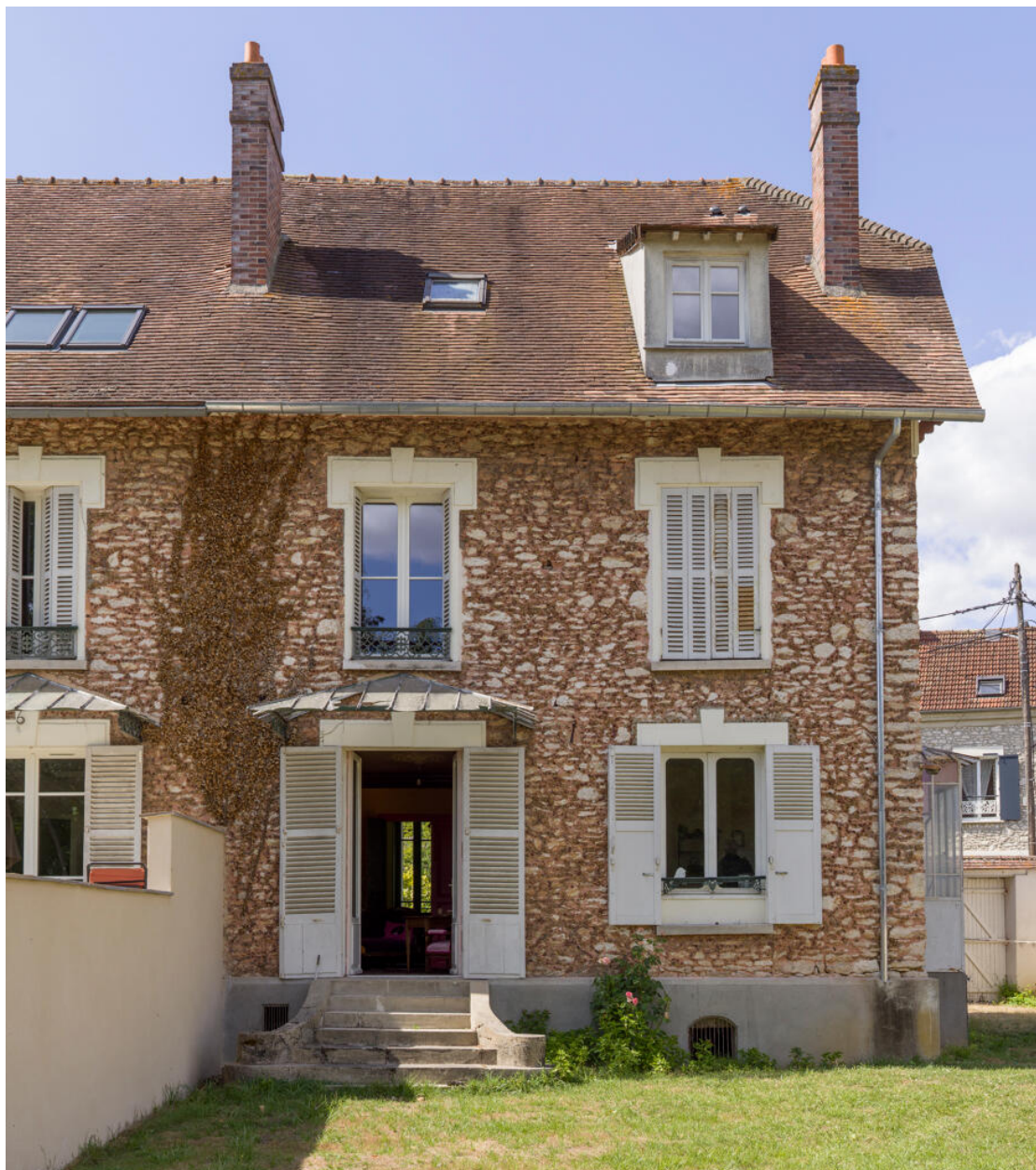
Vue générale de la façade arrière du 25 rue Saint-Pierre depuis le sud.
