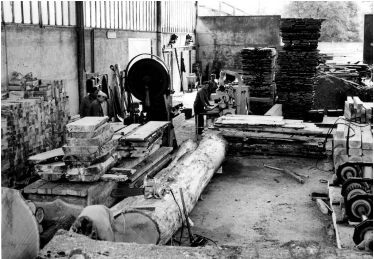
Vue intérieure de la scierie, déligneuse. Photographie. (Collection particulière)
