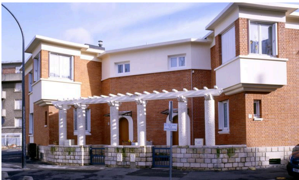
Maisons jumelles reliées par une pergola en béton, rue Proudhon.
