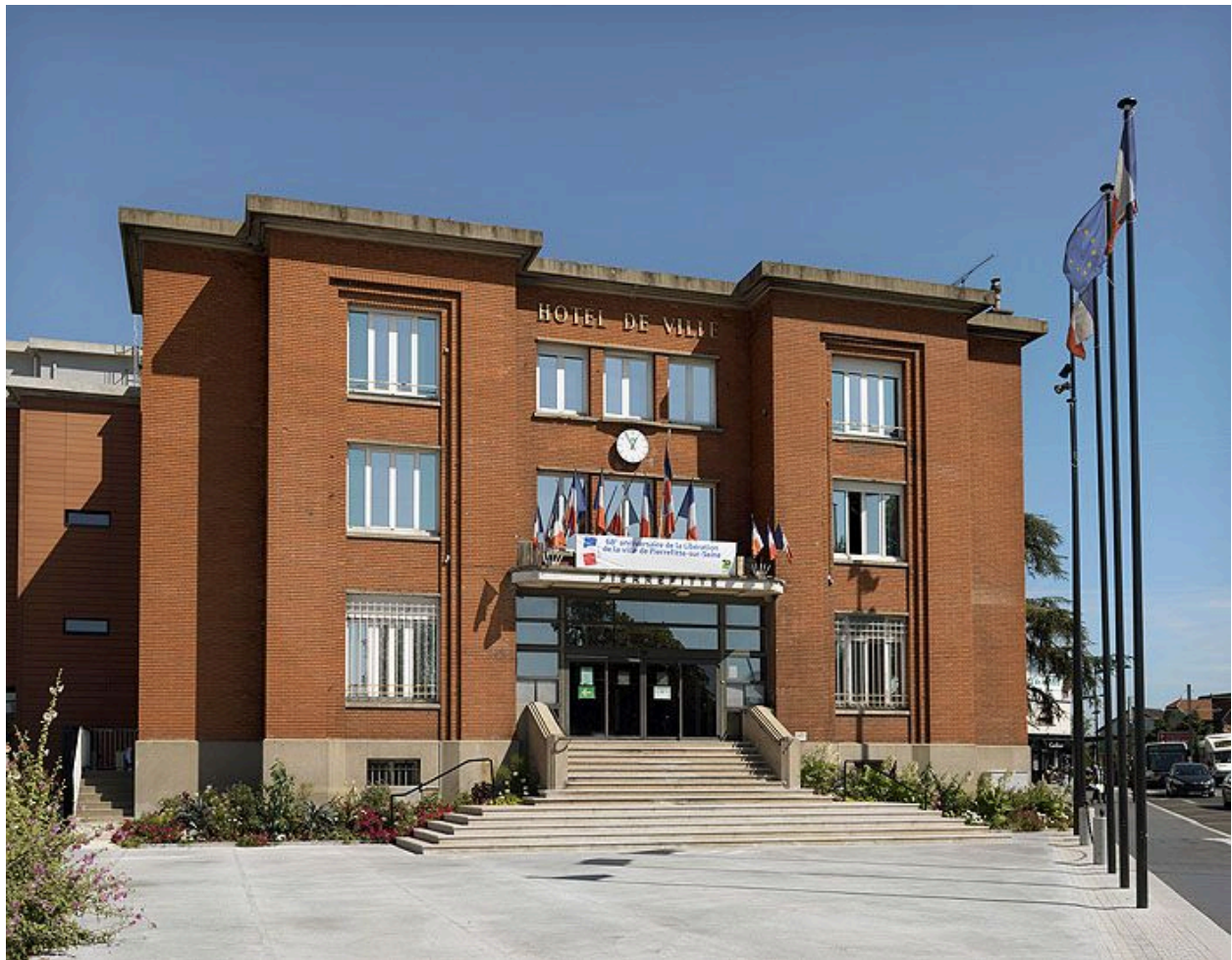
93, Pierrefitte-sur-Seine, hôtel de ville, rue de Paris. Détail du ceps central de la façade antérieure.
