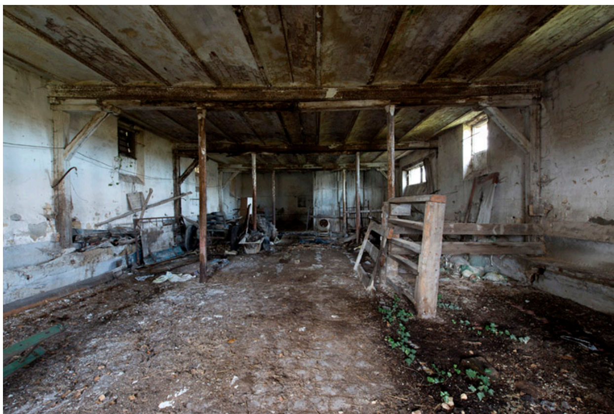
Vue intérieure du rez-de-chausséedu bâtiment dans le prolongement du logement du fermier
