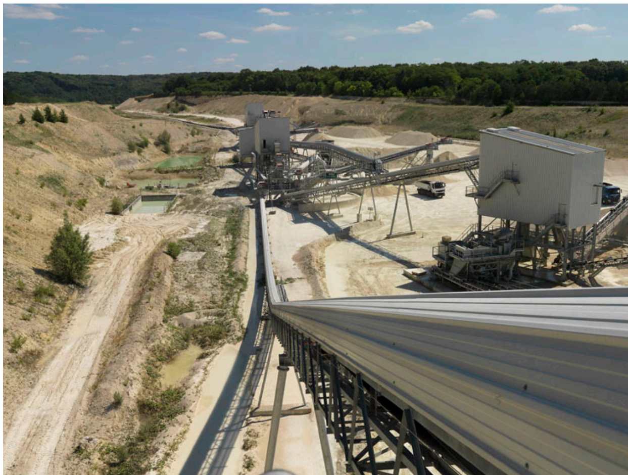
Plateforme - installation secondaire.
