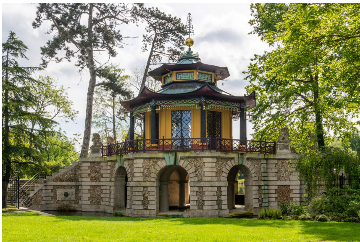
Vue de face, côté déversoir.
