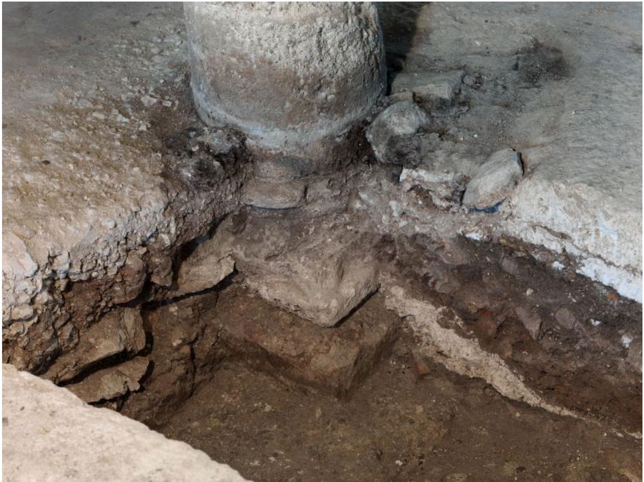
Détail du pilier central de la salle 4 de la grange des Beauvais.
