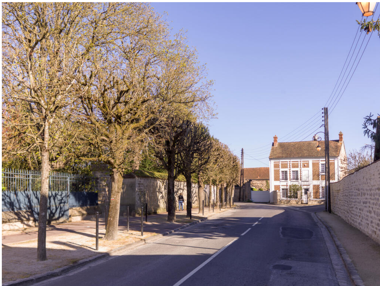
Vue générale de la partie nord du boulevard du Maréchal Foch depuis le sud.
