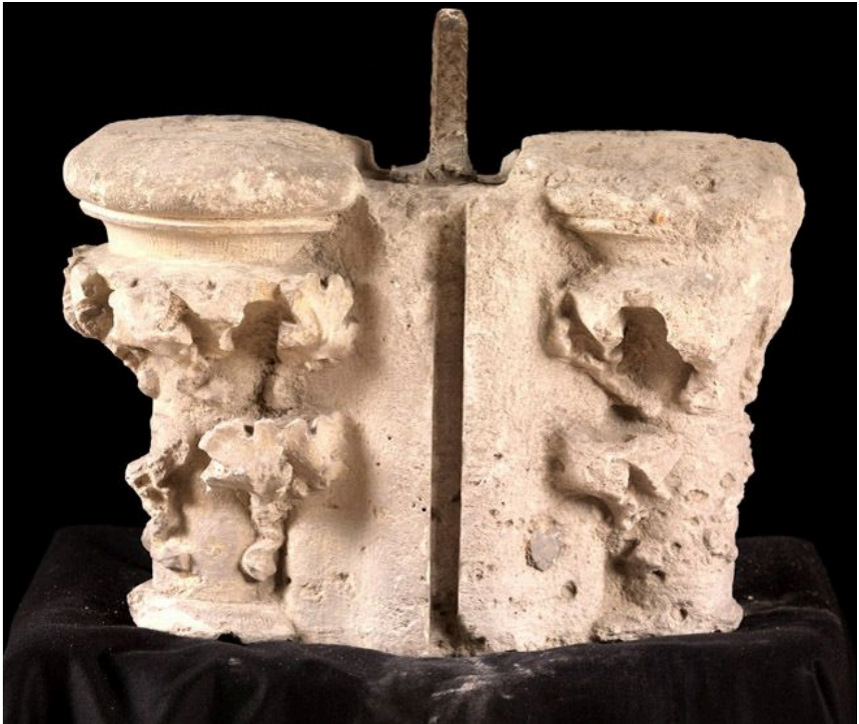
Pièce F23 : morceau de meneau présentant un chapiteau sur chaque face (l'un plus abîmé que l'autre), avec son scellement de fer. Cette pièce provient d'une fenêtre du bas-côté nord du chœur. 2e moitié 13e siècle. Vues des deux sections en 20087700639NUC4A et 20087700640NUC4A.
