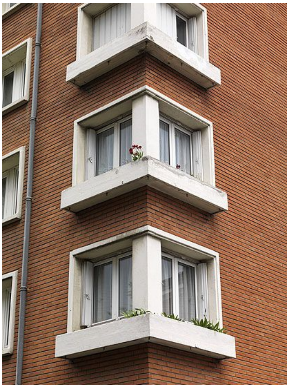
Vitry-sur-Seine, cité dite cité Rosenberg, 101 rue de Choisy. Détail de fenêtres d'angle, de la mise en oeuvre de la brique et des bordures de ciment.
