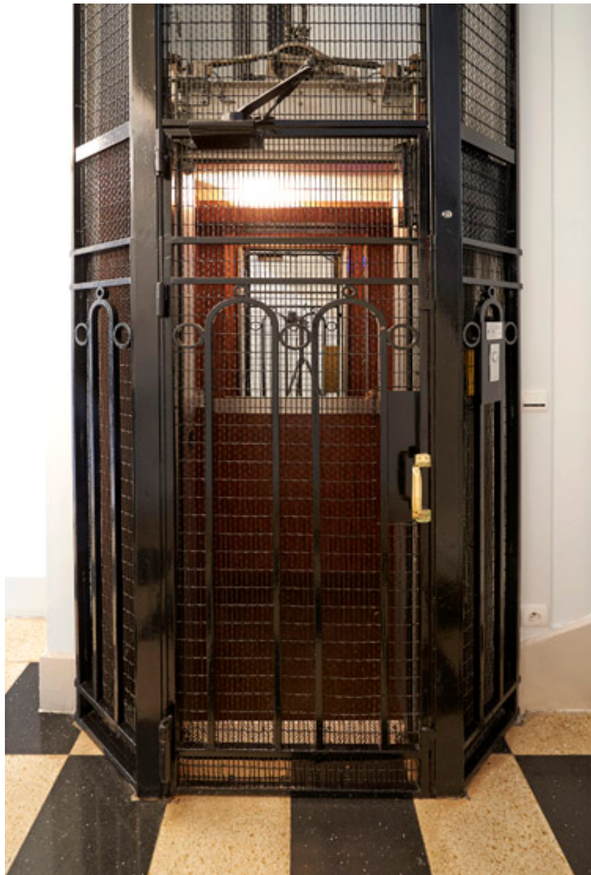
Vue de l'ascenseur principal situé dans la partie droite.
