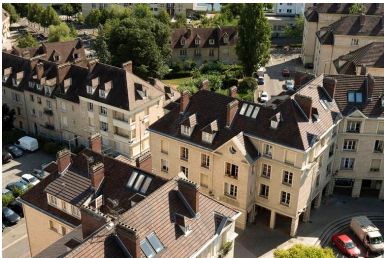
Immeubles reconstruits vus depuis la tour Saint-Maclou.
