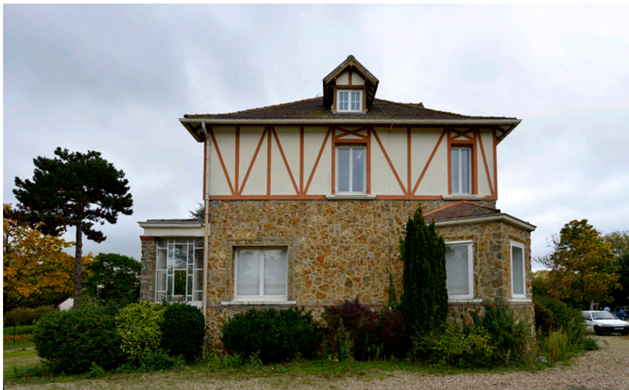
Façade latérale de la maison de notable "les Chênes", 13 avenue du Maréchal-Joffre. Architectes: Sée et Chorein
