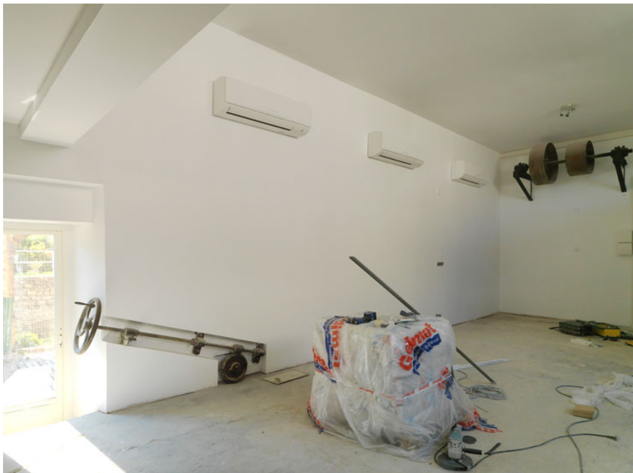
Vue intérieure. Chantier d'aménagement. Vieux outils.
