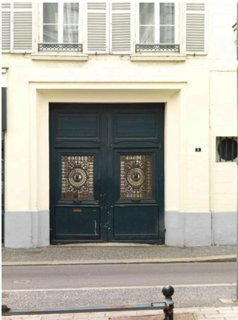
Hôtel, 5 rue Gambetta. La porte cochère est particulièrement soignée.
