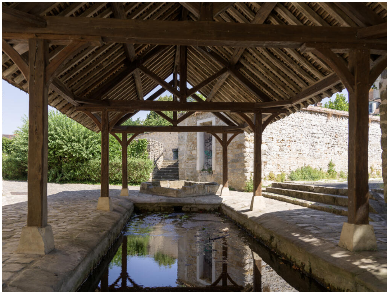
Vue générale intérieure ainsi que du bassin depuis l'ouest.
